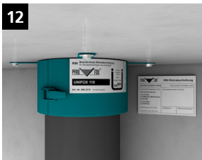
12 Abschließend Rohrabschottung mit Schild kennzeichnen.
