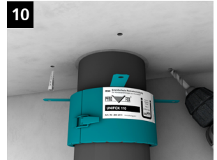
10 Dübellöcher bohren und Dübel setzen.
