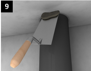
9 Öffnung mit mineralischem Mörtel verschließen.*
