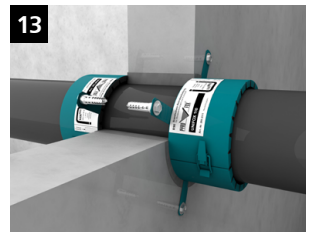
13 Wandmontage: Im Gegensatz zur Decke müssen bei Wanddurchführungen zwei Brandschutzmanschetten angeordnet werden.
