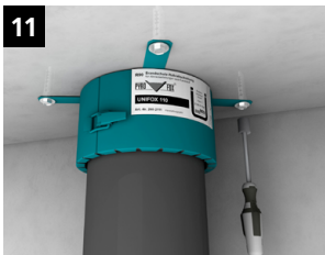
11 Brandschutzmanschette anschrauben.
