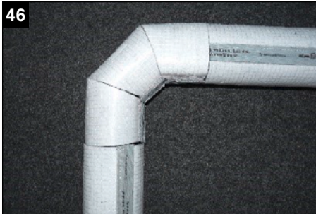
Dämmen der Rohrleitungen
