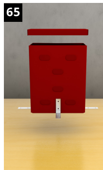
65 Deckel anbringen und mit Klebeband abdichten. Verfüllt das Verfüllen der FST-Kombibox beim Vergießen des Ortbetons.
