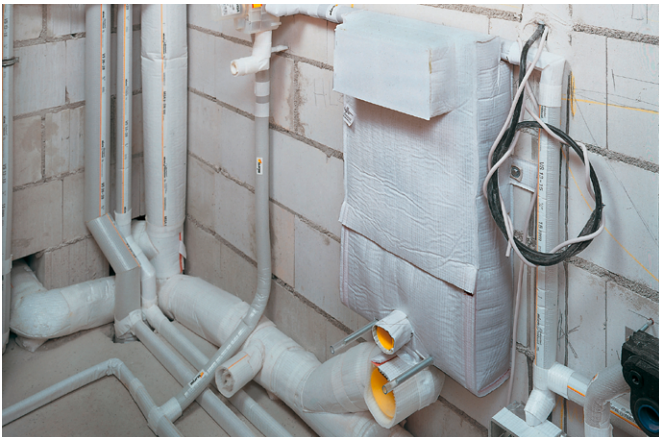
Bild 5 Dämmung von TWK mit Misselfix-Garant sowie Dämmung von weiteren Rohrleitungen und Sanitärerelementen
