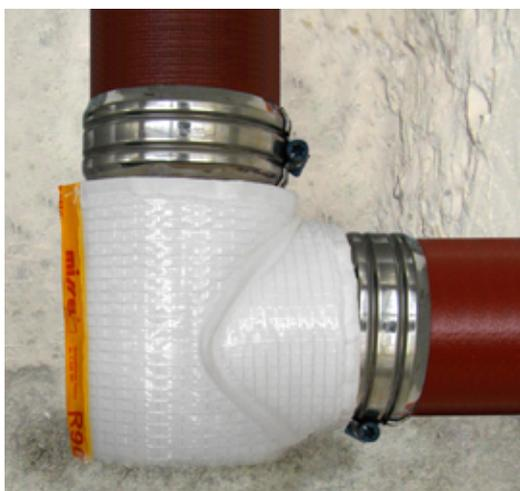
**Bild 34** Passgenaue R90-Formteile für die Formstücke von Abwasserleitungen aus Gusseisen
