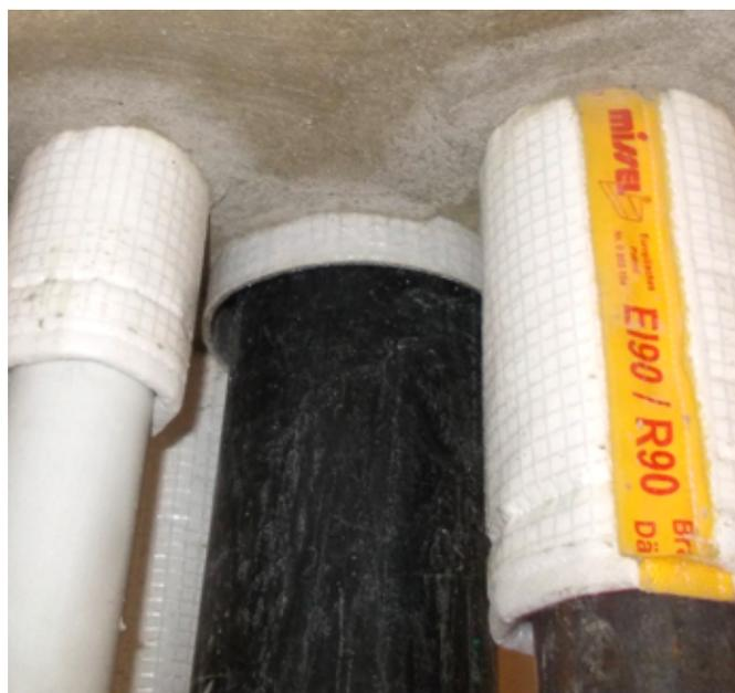
**Bild 50** Missel Brandschutz-Dämm-Manschetten im eingebauten Zustand mit 20 mm Abstand untereinander
