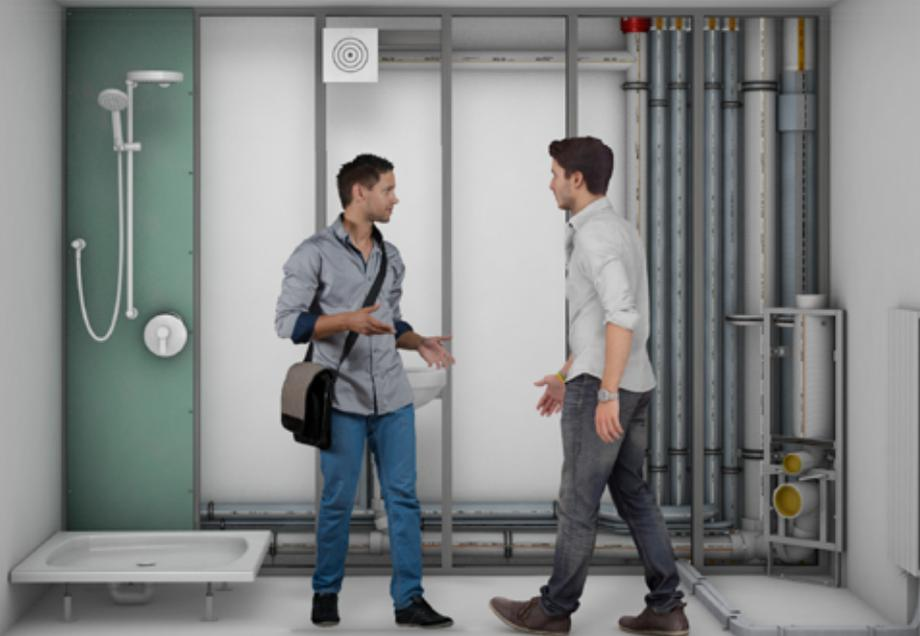
**Bild 1** Durchführung der Rohrleitungen durch Decken und Wände (verschiedene Nutzungseinheiten NE/Wohnungen) nach der Muster-Leitungsanlagen-Richtlinie MLAR (klassifizierte R-Abschottungen oder Erleichterungslösungen)
