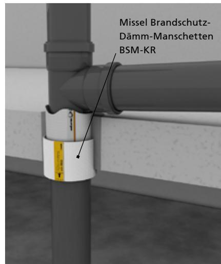
**Bild 21** Abwassersystem vollständig aus Kunststoff – brandschutztechnische Absicherung nach MLAR/Abschnitt 4.1 (R90-Abschottung)
