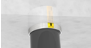
Brennbare Ab- und innenliegende Regenwasserleitungen
