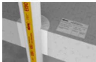
Die Ringspaltbreite darf 5 mm bis 30 mm betragen.
