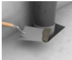
Restöffnung in Bauteildicke mit mineralischem Mörtel verschließen.
