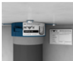
Anschrauben und Rohrabschottung mit Kennzeichnungsschild kennzeichnen.
