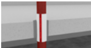
Abwasserleitungen aus Guss
