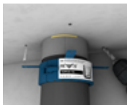
Dübellöcher bohren und Dübel setzen.
