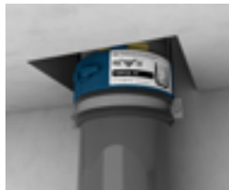
Manschette aufsetzen und schließen. Eine Rohrschelle zur Positionierung ist hilfreich.
