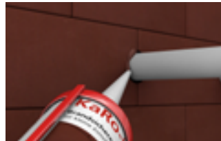
Auffüllen von Ringspalten: Dichtmasse zum Fugen- und Zwickelverschluss
